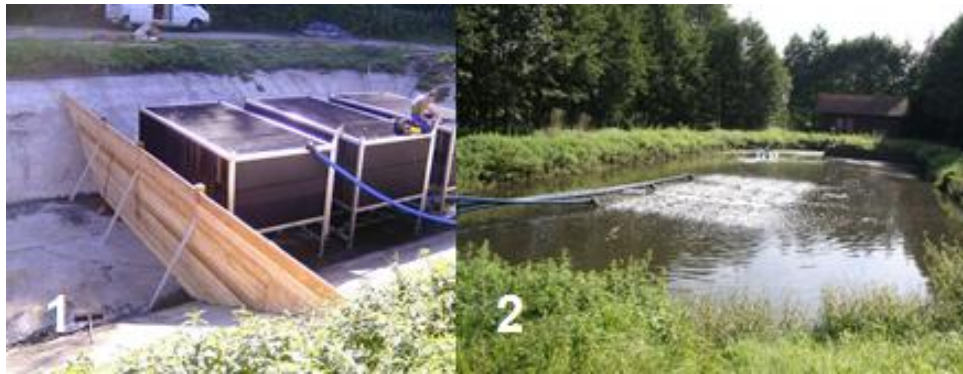
Bild 6: Ertüchtigung einer Teichkläranlage durch die Nachrüstung von getauchten Festbetten (1 = Bauphase, 2 = nach Inbetriebnahme)
