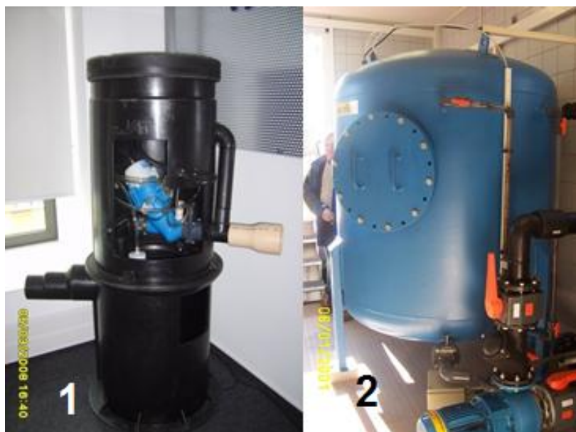
Bild 11: Vakuumentwässerung (1 = Hausanschlussschacht, 2 = Vakuumstation)
