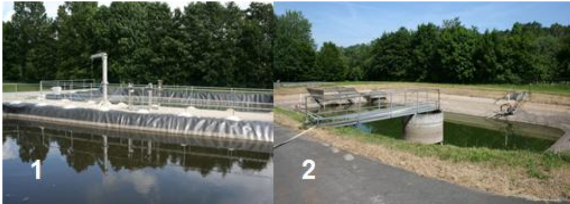
Bild 7: Umbau alter Abwasserteiche (1 = Umbau eines Schönungsteiches in ein Nachklärbecken und einen Schlammstapelbehälter, 2 = Umbau eines Abwasserteiches in ein Regenüberlaufbecken)
